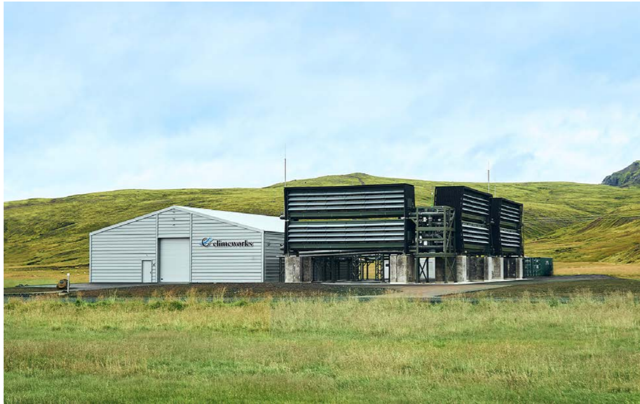
DAC-Anlage „Orca“ auf Island, 2021.
